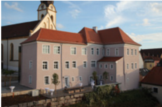
vhs Schwandorf bezieht den sanierten historischen Pflegehof.
